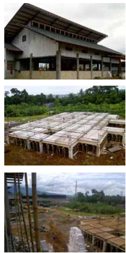
Proses pembangunan AMC.
