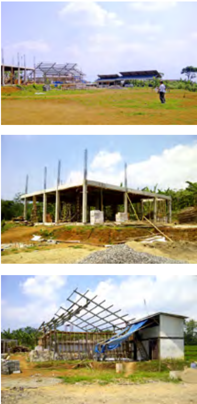
Proses pembangunan AMC.
