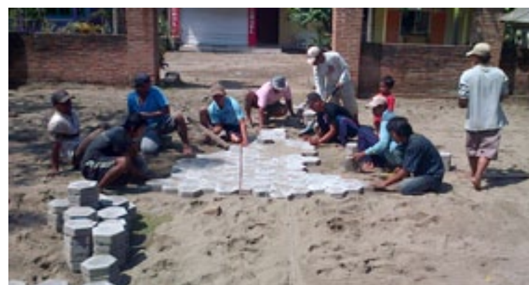
Kerja bakti memasang paving seluas 6 m x 12 m di halaman Wihara Dhamma Santi, Desa Kandangan, dana dari Yayasan Ehipassiko, 16 Sep 2012.
